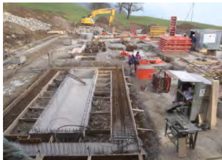
Anbau Stall Birchen in Ennetbüren
