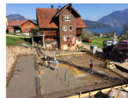
Neubau 3-FH Lielibach 1 in Beckenried
