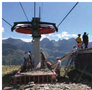
San. Steherfundament Haldigratbahn
