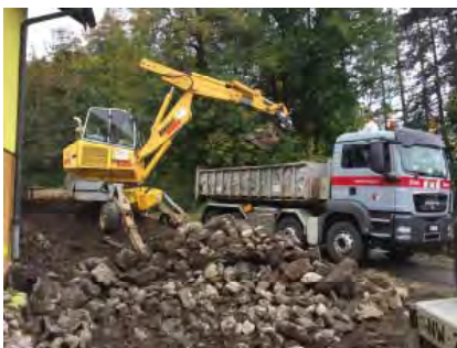
Um- u. Anbau Pfadhütte, Beckenried
